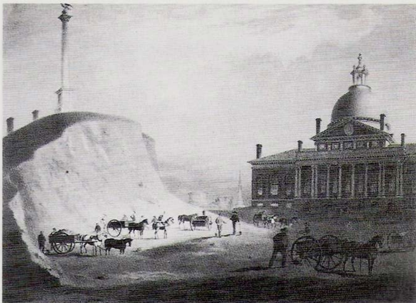
Cut down of Beacon Hill バックベイ埋立のため、ビーコンヒルの土砂も削り取られた。
