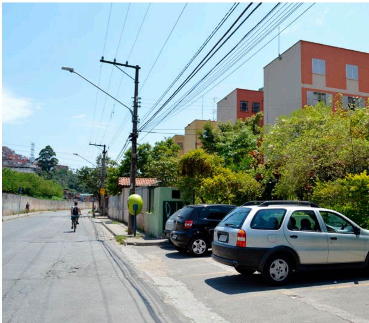
Figura 56: Conjuntos habitacionais na Travessa Igarapé Primavera
