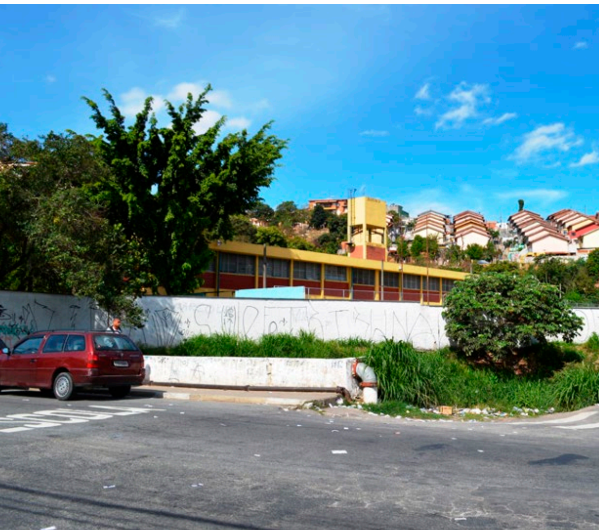
Figura 19: O muro da Escola Estadual Prof. Eunice T. de O. Fráguas separa o pátio das margens do córrego
